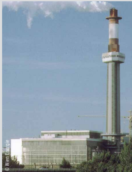
Die Anlage Spittelau vor dem Großbrand 1987 ...
